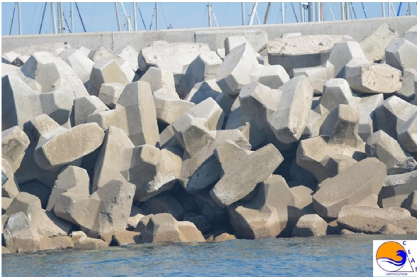
Конструкция ACCROPODE™, демонстрирующая много дефектов технологии укладки блоков, отсутствие контактов и преждевременное разрушение.
