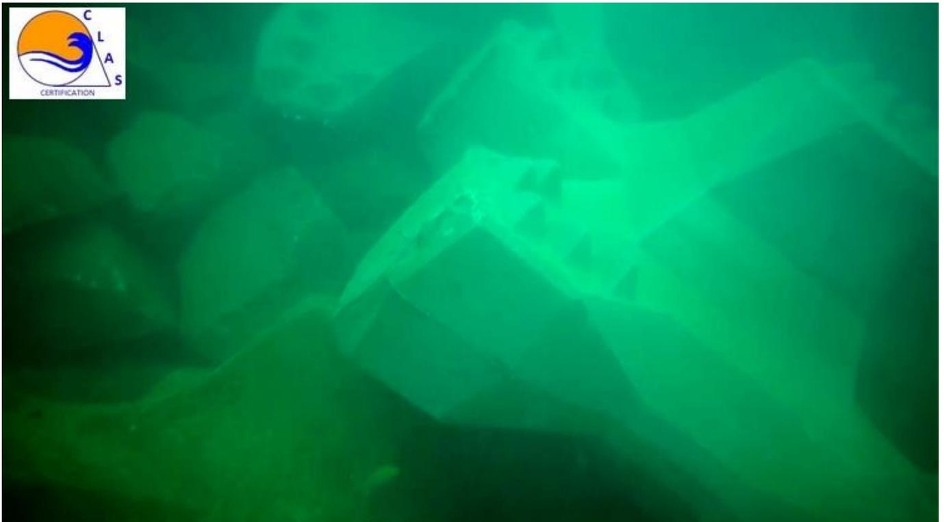
По факту блоки были смонтированы вторым слоем прямо на разрушенный штормом первый слой
