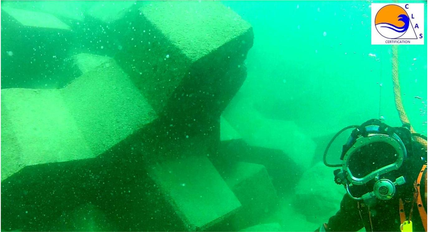
Компания CLAS курировала реконструкцию 5000 м мола X-BLOC® в качестве третьей стороны. **Это плохо построенная конструкция, с грубыми нарушениями технологии.**
