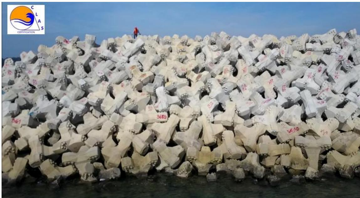
Sur la base des rapports de **TECHNOLOGY COMPLIANCE** établis par les inspecteurs de CLAS, les carapaces ACCROPODE™, ACCROPODE™II, ECOPODE™, CORELOC™ et X-bloc® peuvent être approuvées sans réserve comme étant conformes au design et à la technologie et validées carapaces
