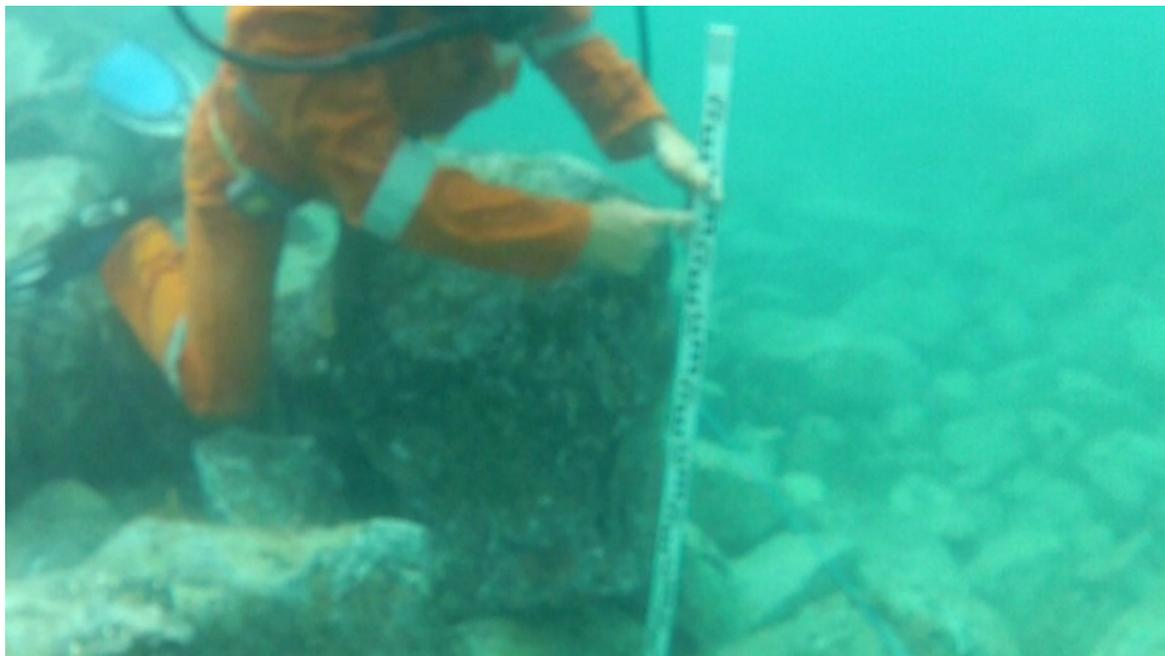
Когда подложка и горизонтальный брем одобрены, допускается укладка блоков ACCROPODE™, ACCROPODE™II, ECOPODE™, CORELOC™ или X-bloc®
