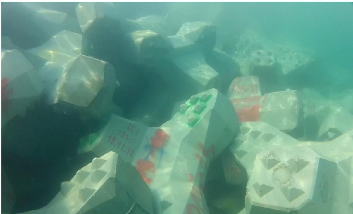
Затем компания должна установить упорные камни перед тем, как устанавливать блоки над поверхностью воды. До тех пор, пока подводная часть армура не будет надлежащим образом закреплена упорными камнями, блоки ACCROPODE™, ACCROPODE™II, ECOPODE™, CORELOC™ или X-bloc® над водой не должны укладываться.
